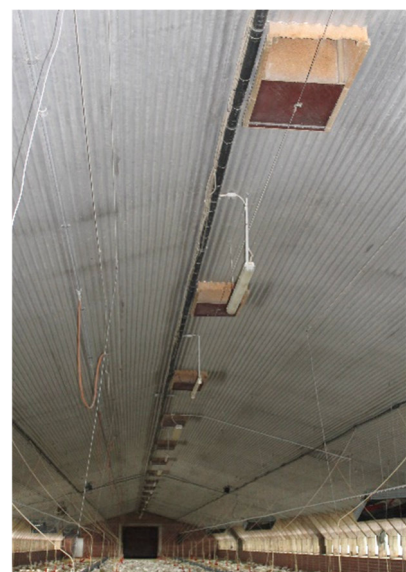
Abb. 3 Offenstall mit geöffneten Firstöffnungen; Innenansicht
