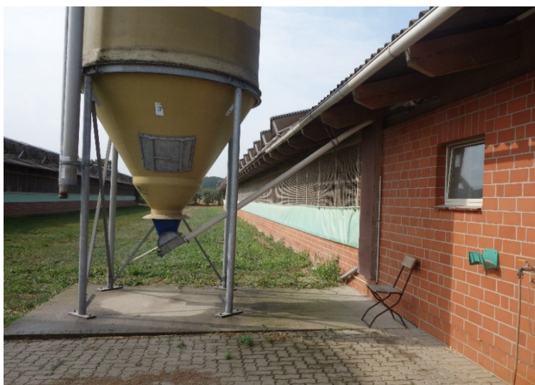
Abb. 2 Offenstall, hier mit geöffneten Jalousien, Außenansicht
