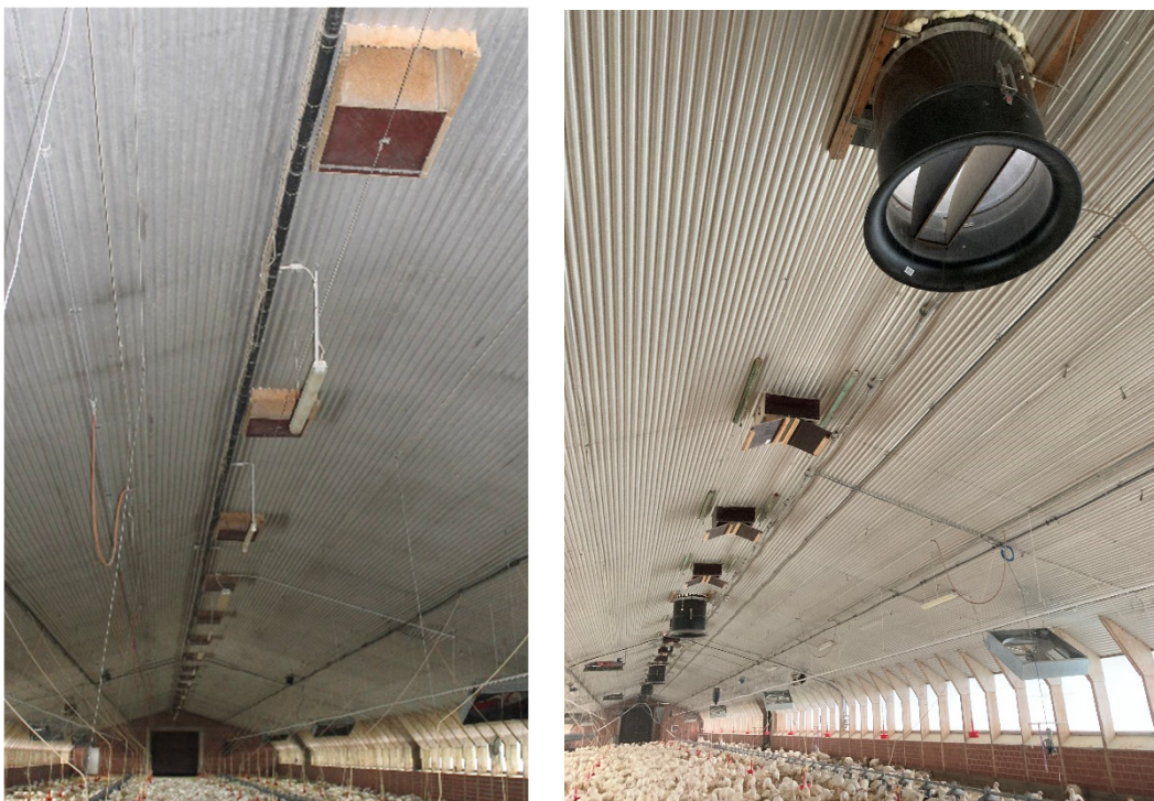
Abb. 5 Links: Vor dem Umbau der Firstöffnungen. Rechts: Durch den Umbau wurden die Firstöffnungen durch regelbare Lüftungsklappen ergänzt, außerdem wurde ein Teil der Firstöffnungen durch Abluftschächte ersetzt.
