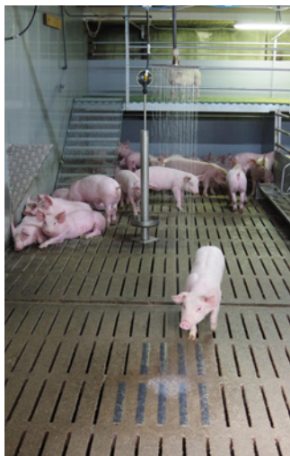
Abbildung 53, Folie 46: Schweinedusche in der Buchtenmitte installiert. Unter der Dusche sind die Spalten mit Spaltenverschlussleisten geschlossen, um die Feuchtigkeit zu sammeln. (© MuD Tierschutz, BLE)
