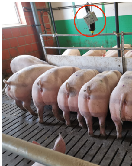
Abbildung 36, Folie 22: CO 2 - und Ammoniak-sensoren über dem Trog (© L. Schönberg)
