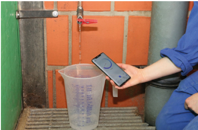
Abbildung 59, Folie 53: Prüfung der Durchflussrate mit Messbecher und Stoppuhr. Mithilfe einer Wäscheklammer kann das Wasser bequem eine Minute laufen gelassen werden, um die Durchflussrate pro Minute zu ermitteln. (© L. Bütfering)
